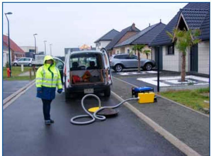
La Communauté d'Agglomération du douaisis a récemment procédé à la vérification de la conformité du réseau d'assainissement du lotissement situé rue de Brunémont.
