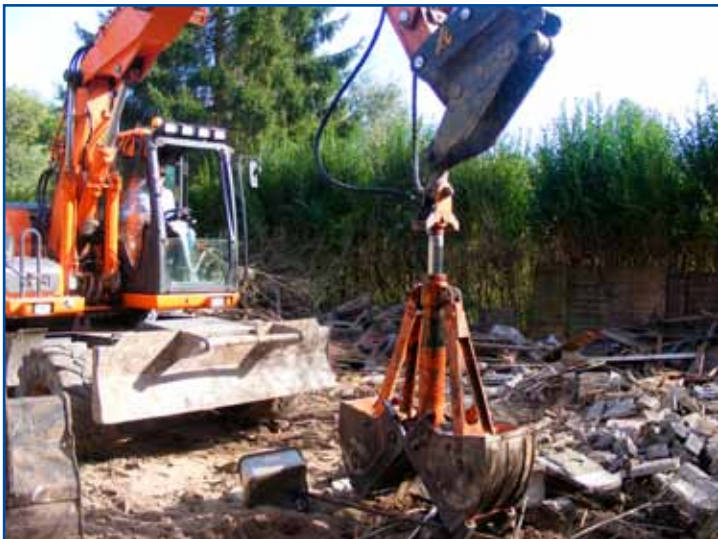
Destruction de friche.
