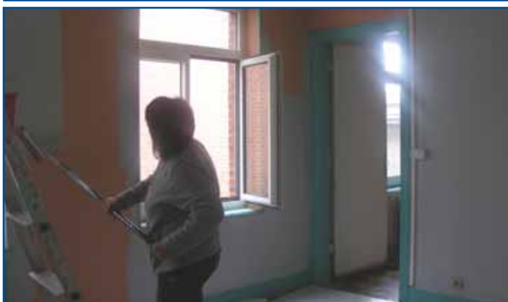
La PMI (Protection Maternelle Infantile) est transférée à l'ancienne bibliothèque (grand'rue), quelques derniers travaux sont en cours.
