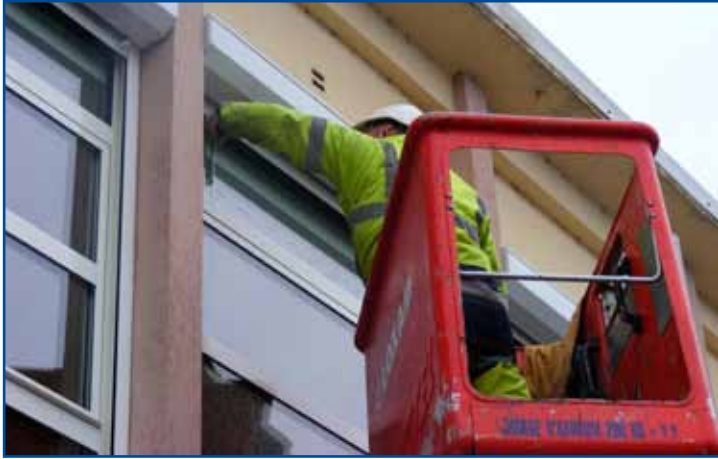
Disposant de la capacité de piloter une nacelle, nos employés communaux ont procédé à divers travaux en hauteur (ici nettoyage de vitres à l'école F.Noël).
