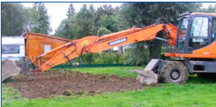
Destruction de dalles en béton au camping municipal.
