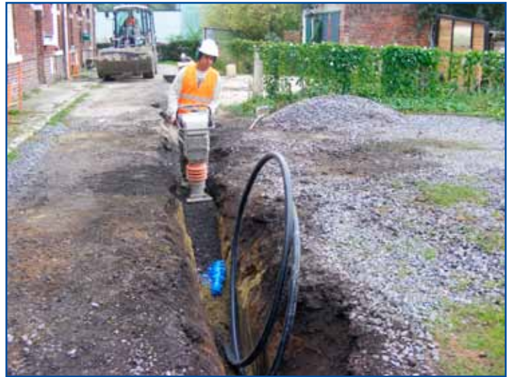
Adduction normalisée d'eau et réduction des branchements plomb à la cité Guyot (Siden).
