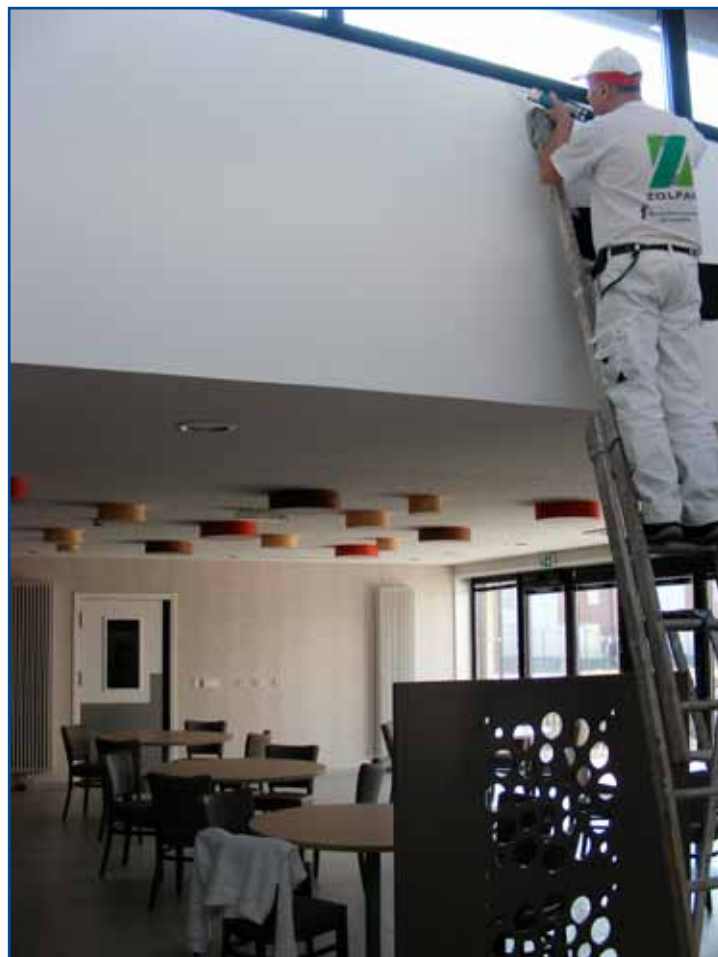
Dernières touches de finitions.
