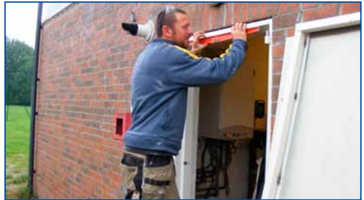
Remplacement de la porte de la chaufferie au complexe sportif.
