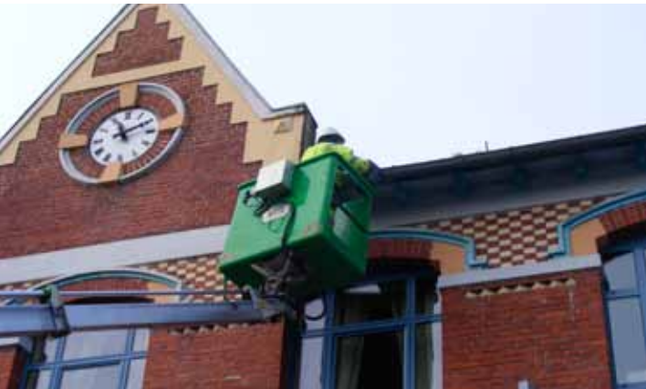
Nettoyage à la nacelle des gouttières des bâtiments communaux
