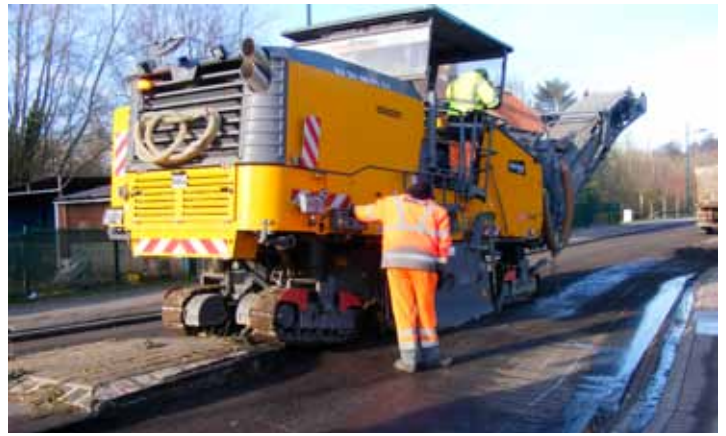
Réfection par le Conseil Départemental de la voirie rue de Douai et rue de la Chaussée
