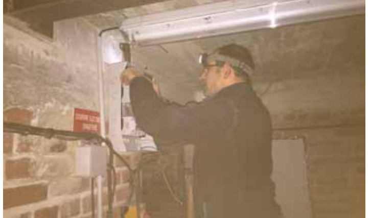
Travaux électriques liés à la sécurité à l'école François Noël
