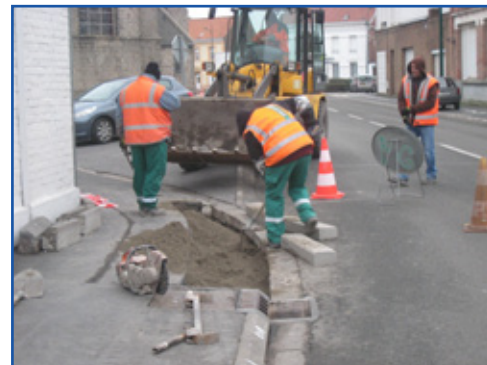
Abaissement des bordures aux passages piétons (coeur de village).
