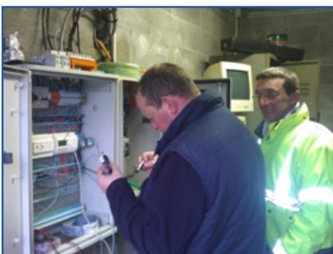
Travaux Intérieurs et extérieurs au terrain de bicross (Collaboration bénévoles et mairie).
