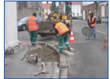
Baisse des bordures pour faciliter le passage des poussettes et des fauteuils
