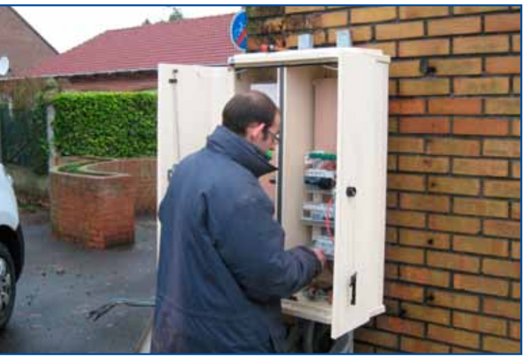
Changement complet de l'armoire de commande d'éclairage public du lotissement PA.Merlin.
