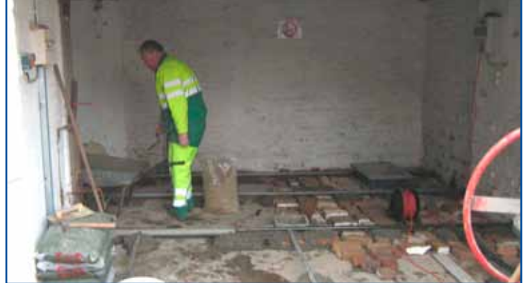
Modernisation du local de cuisine pour la Foire à l'ail fumé.
