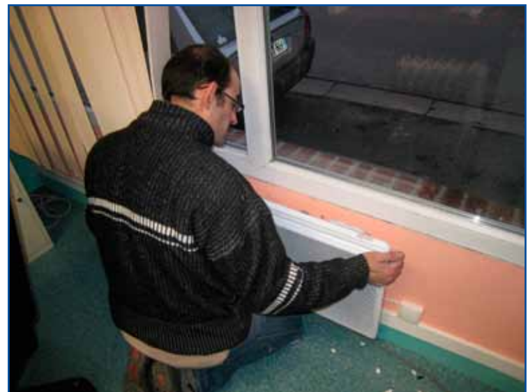
Pose d'un nouveau système de chauffage, à la bibliothèque municipale.
