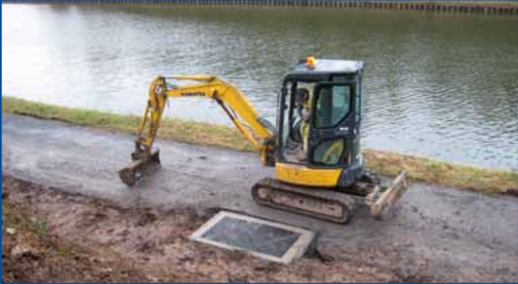
Pose d'une chambre pour le futur dégroupage total des télécommunications.
