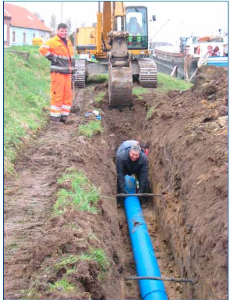
Pose d'une canalisation d'adduction d'eau (direction Marquion). La sécurité incendie sera, au passage, améliorée rue du bias.
