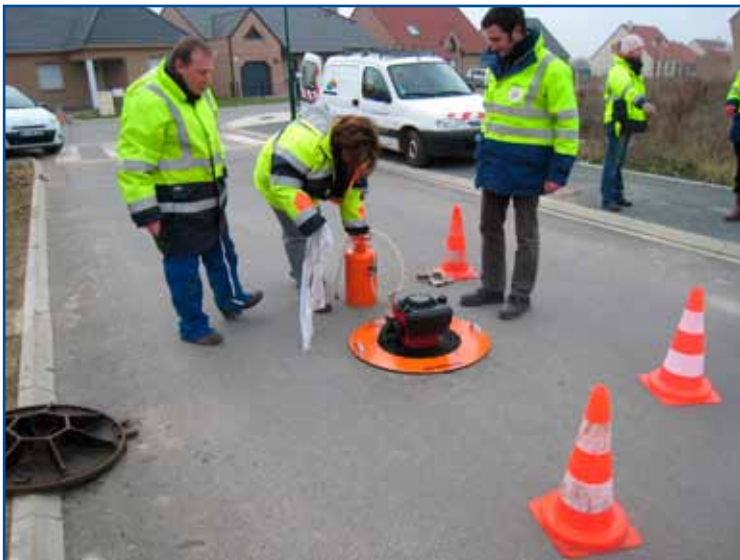
Tests de conformité du réseau d'assainissement du lotissement des berges du canal.
