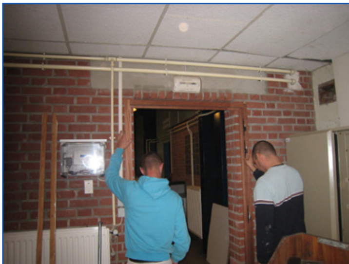
Modification du local de stockage à la salle des fêtes.
