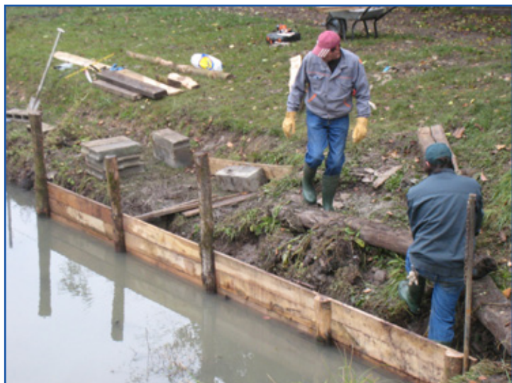
Remise en état du 1er port à bateaux, au marais communal.
