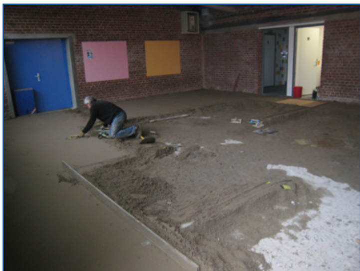
Travaux de réhabilitation du hall d'accueil de la Maison Pour Tous.
