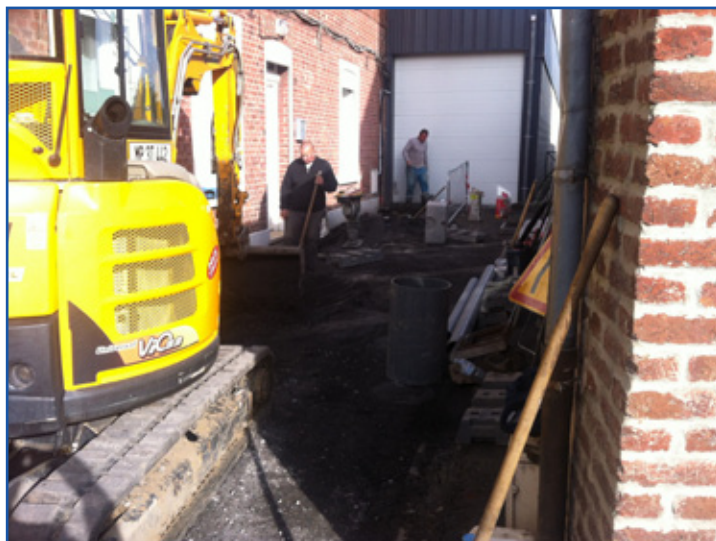
Remplacement de canalisation d'eau usée en domaine public.
