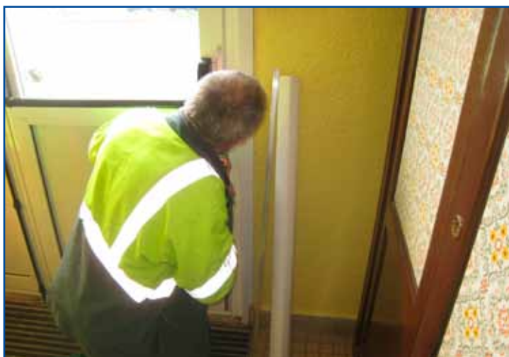
Travaux à l'école F.Noël (services municipaux).
