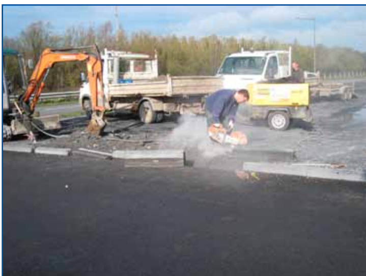
Amélioration de l'accès pour le parking annexe de la gare.
