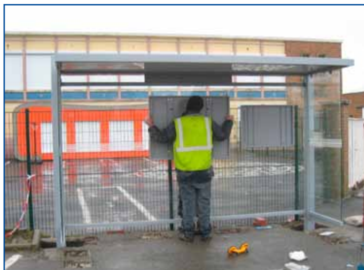
École F.Noël, dépose de l'ancien abribus par les services municipaux et pose du nouveau par le Syndicat des Transports (S.M.T.D).
