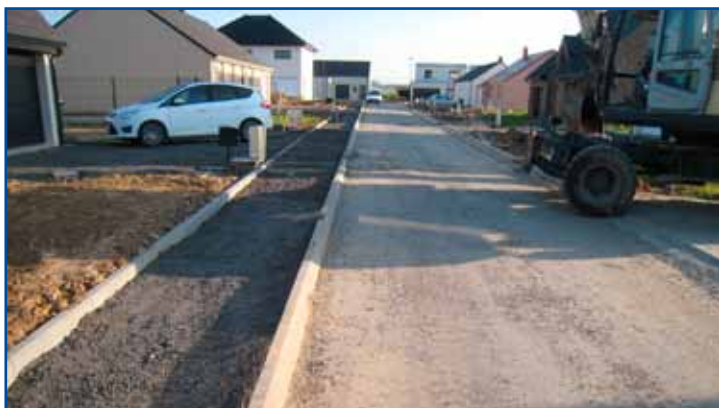
Travaux de finitions, voie des meuniers.
