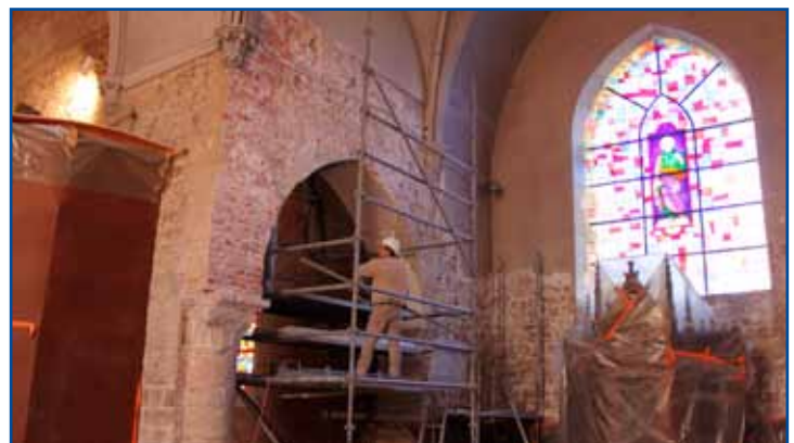
Église, fin du piquetage.
