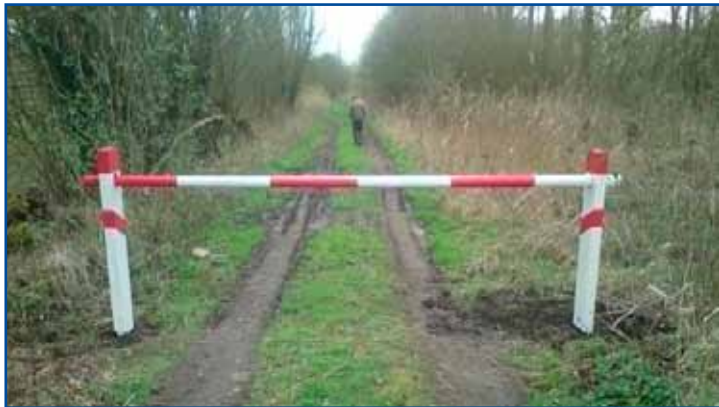
Pose de barrières sur le chemin vert.
