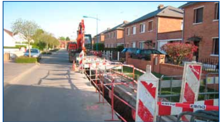
Rue du 8 mai, adduction d'eau et d'électricité pour le futur EHPAD.
