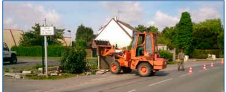
Pose de clôture, salle des fêtes.
