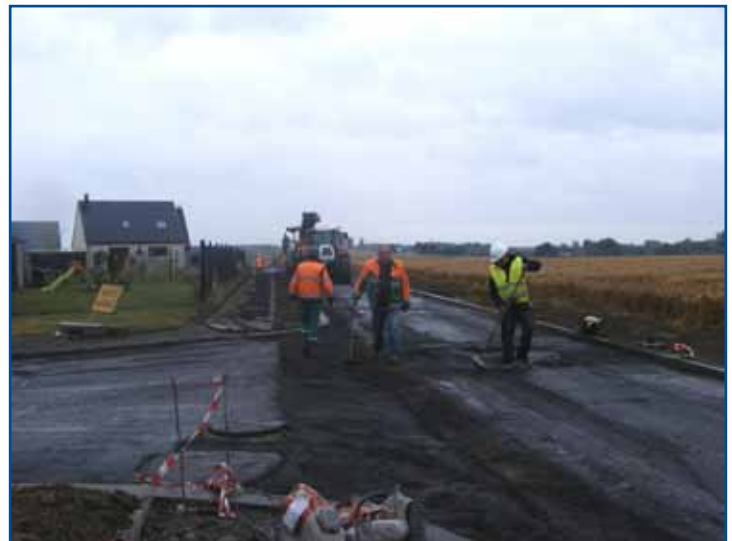
La dernière couche de roulement sera posée très prochainement.
