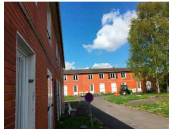
Locaux vétustes de l'ancienne gendarmerie à raser
