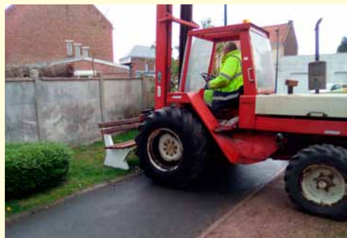
Face au nouveau banc près de l'église, les anciens cailloux rouges seront remplacés par une partie engazonnée
